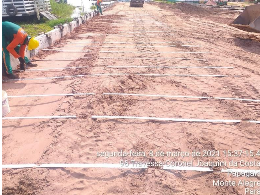
Fotos 27 e 28 - Montagem de placas, aterro e enrocamento externo
