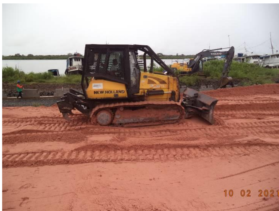
Fotos 19 e 20- Fornecimento, espalhamento e compactação de aterro
