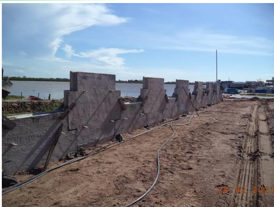
Foto 23 – Dique de contenção e bomba de esgotamento de água
