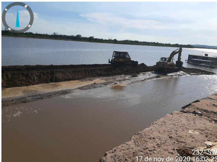
Foto 04- Execução de Dique de Contenção- Complemento TRECHO 01- Segmentos 09, 08 e 07
