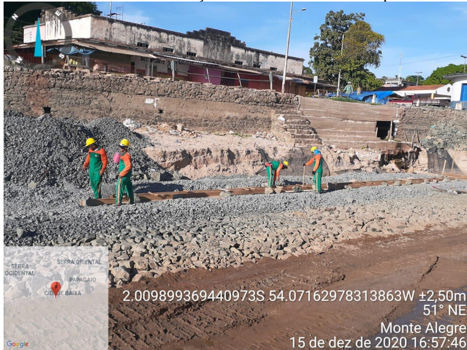
Fotos 07 e 08 - Execução de soleira em concreto simples
