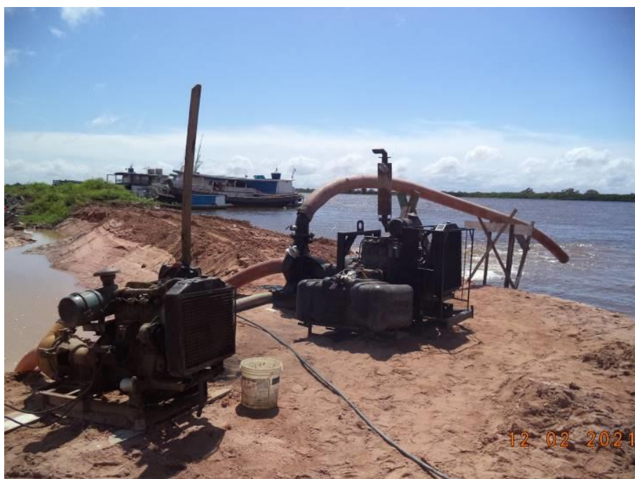
Foto 23 – Dique de contenção e bomba de esgotamento de água
