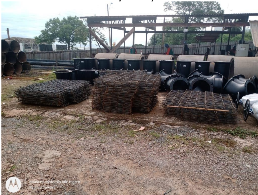
Foto 06 - Fornecimento do aço e armação das escamas de concreto
