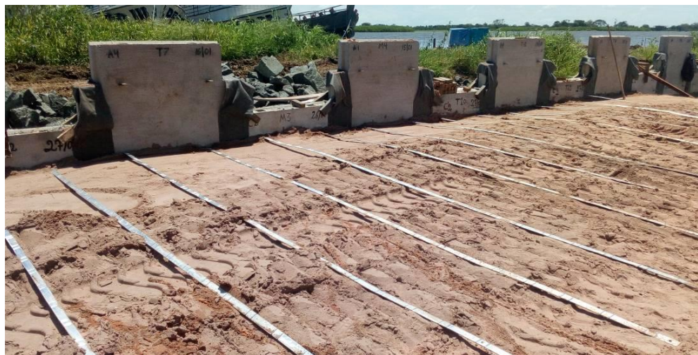
Fotos 19 e 20- Fornecimento, espalhamento e compactação de aterro
