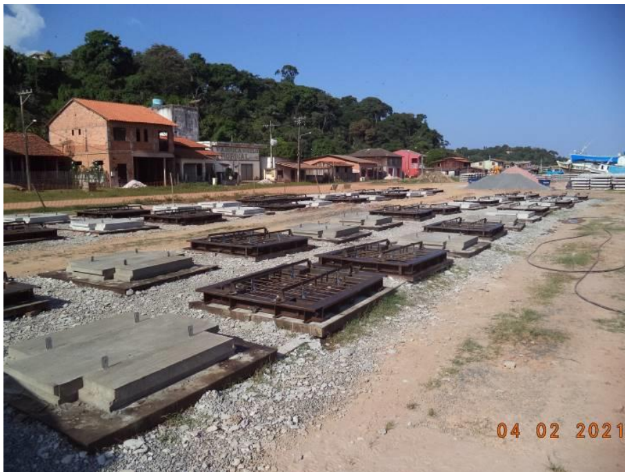
Fotos 21 e 22- Fabricação, montagem e instalação de fita metálica das placas de contenção
